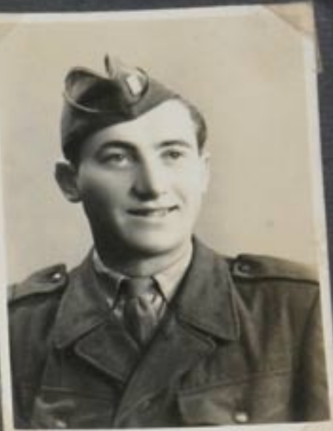
Jindřich Moravec, * roku 1925 v Čechovicích čp. 18. -
