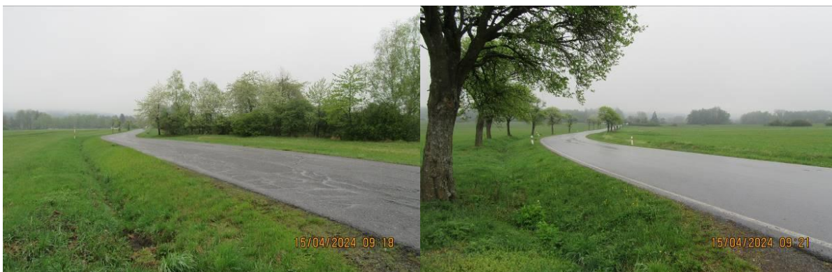
Silnice II/177, vlastní foto z terénního průzkumu
