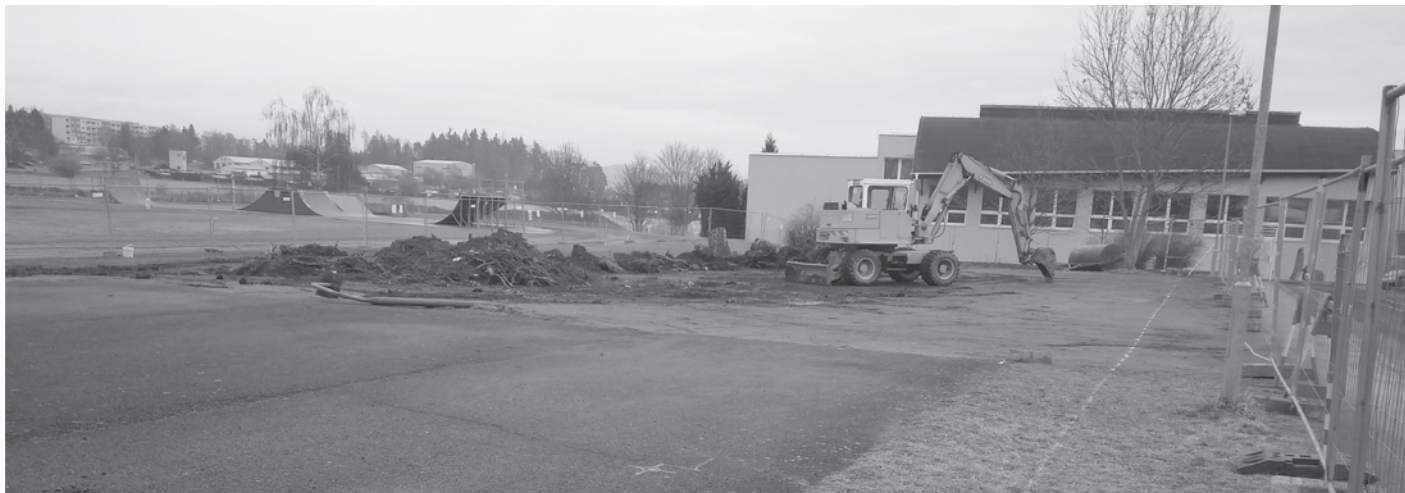
Začala stavba multifunkčního hřiště u školy, foto archiv ZŠ
